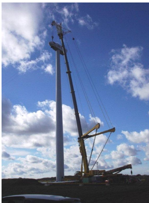
Illustration 32 : Construction du parc éolien de Boquého Plouagat - Février 2017
